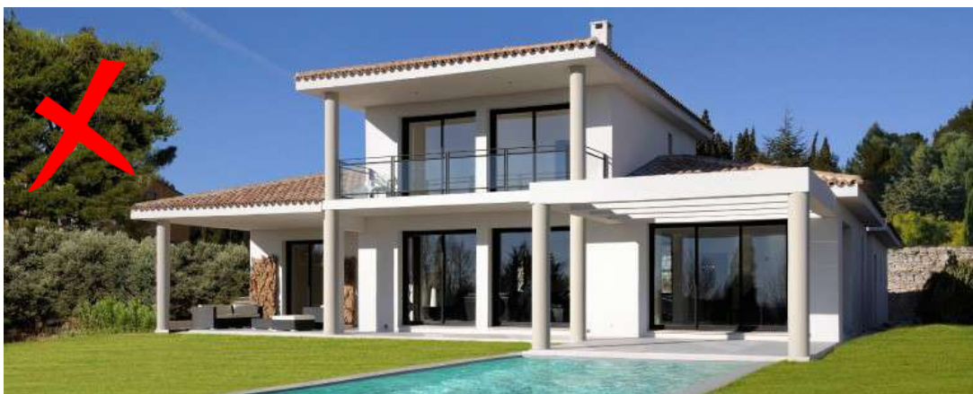
Répétition ennuyeuse de baies vitrées formant vitrine, hors contexte à Poleymieux
